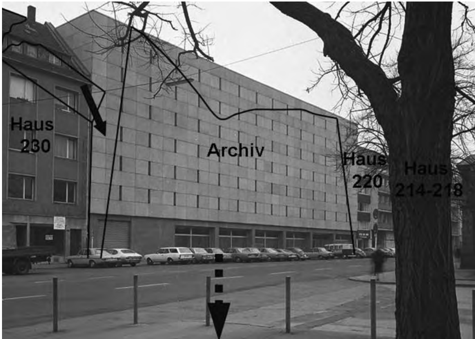
Abb. 4: Archivgebäude mit Abbruchkante. (Foto: Berufsfeuerwehr Köln)
