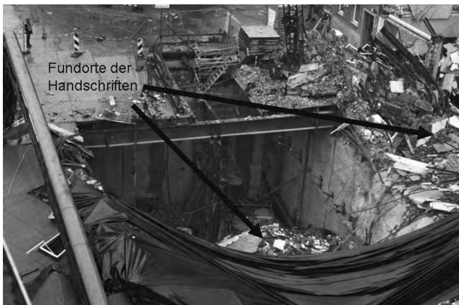
Abb. 5: Ein Blick in das Gleiswechselbauwerk. (Foto: Berufsfeuerwehr Köln Jürgen Schütze)
