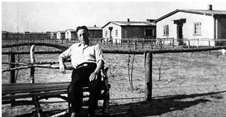
Abb. 9: Blick auf die Baracken des Marine-Gemeinschaftslagers. (Foto: Kreisarchiv OHZ)
