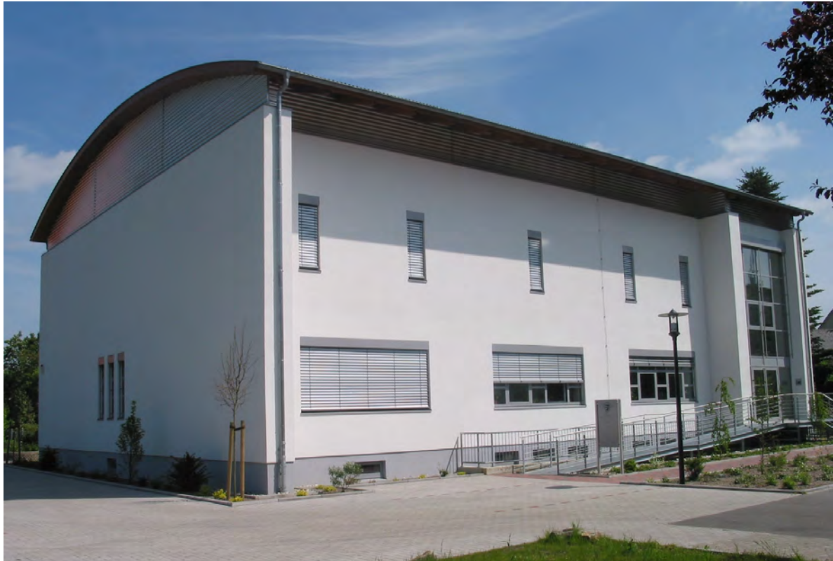
Archivgebäude, Rampe für Behinderte und Aktenanlieferung, Magazinräume im Obergeschoss (Südwestansicht)
