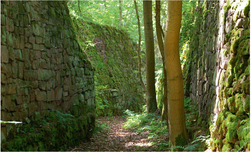
Abb. 10: Stützmauern von Abraumhalden der Steinbrüche im Hoopthal (Foto: Ansgar Hoppe)
