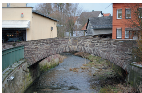
Abb. 6: Brücke von 1742 über die Lenne in Eschershausen
