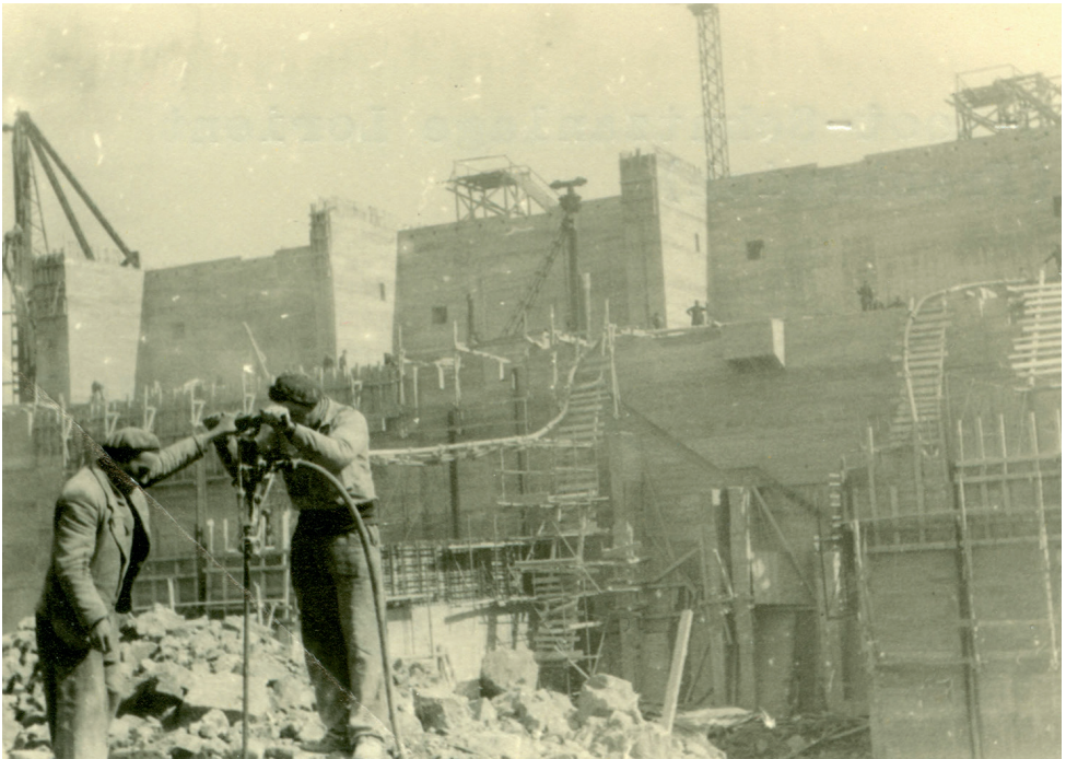
Abb. 4: Bauarbeiten zum U-Boot-Bunker in Lorient – Beispiel aus dem Bildarchiv der Philipp Holzmann AG im BBWA
